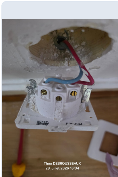
📷 Prise déposée avec conducteurs rouge et bleu uniquement au mécanisme.
