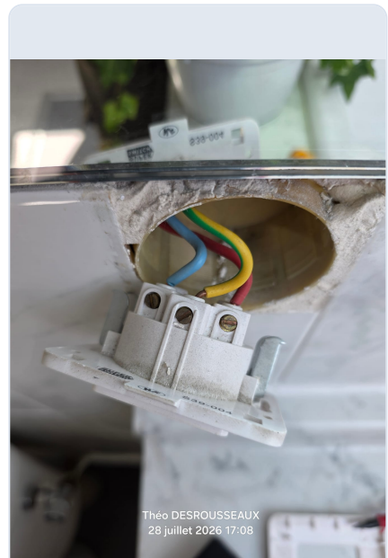
📷 Prise déposée avec rouge, bleu et vert/jaune présents dans la boîte.
