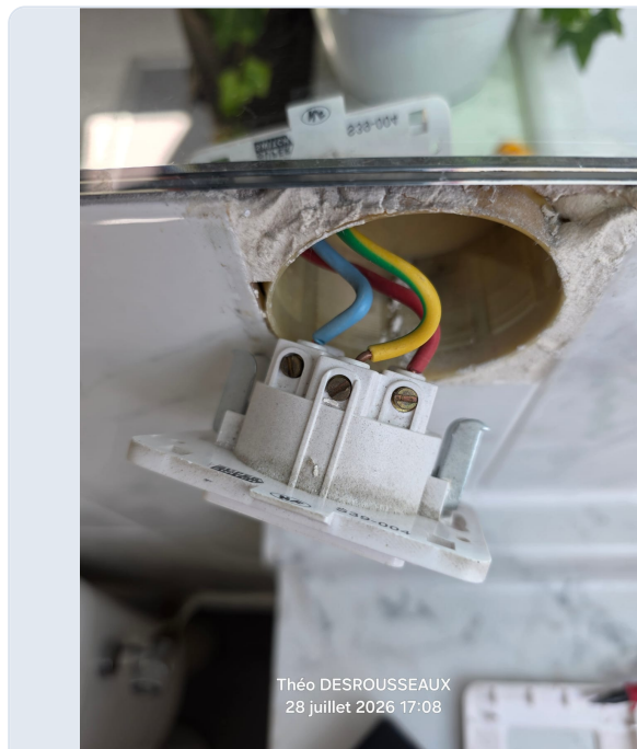
📷 Prise déposée avec rouge, bleu et vert/jaune présents dans la boîte.
